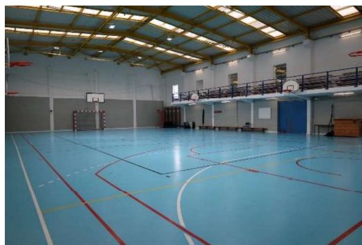
Fig. 169 – Beneficiação interior do pavilhão desportivo da EB João Gonçalves Zarco
